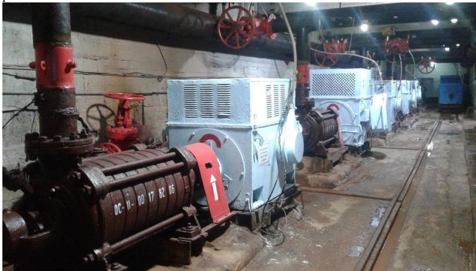
**Водоотлив** – необходим для удаление шахтных и карьерных вод из шахтных выработок.
